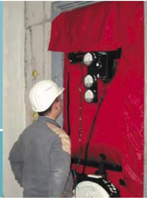
Abb. 3: Messung der Gebäudedichtheit mit dem Drucktest (Blower Door)
